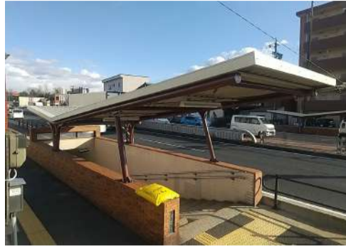
弁天地下横断歩道(屋根取替え)
