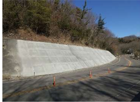
21号土岐地区(法面簡易吹付法枠)
