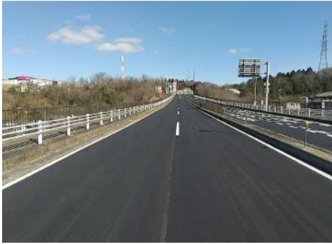
19号土岐地区(舗装工)
