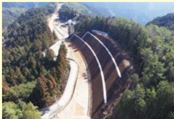
国道 418 号潮見地区改良工事
