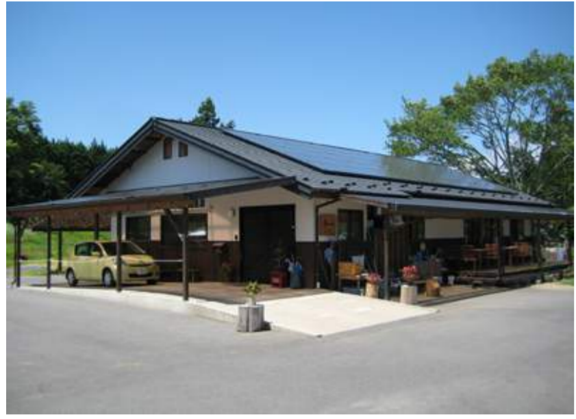
くわのみみデイサービス棟に設置された太陽光発電9.9kwシステム。 恵那市岩村町飯羽間
